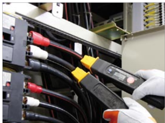
Rys. 3. Wykonywanie pomiarów miernikiem HIOKI 3258
